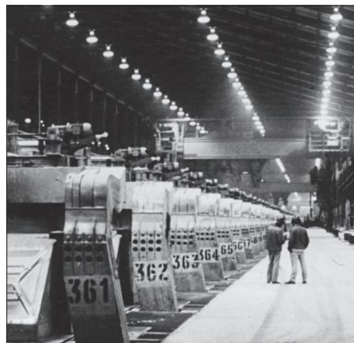
**Рис. 1.10.** Серия электролизеров для производства алюминия (с разрешения «Comalco Ltd.»)
