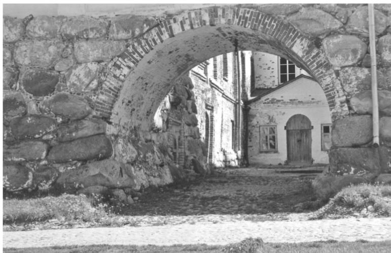
**Рис. 1.6.** Стены монастыря с арочным кирпично-валунным перекрытием (фото автора)
