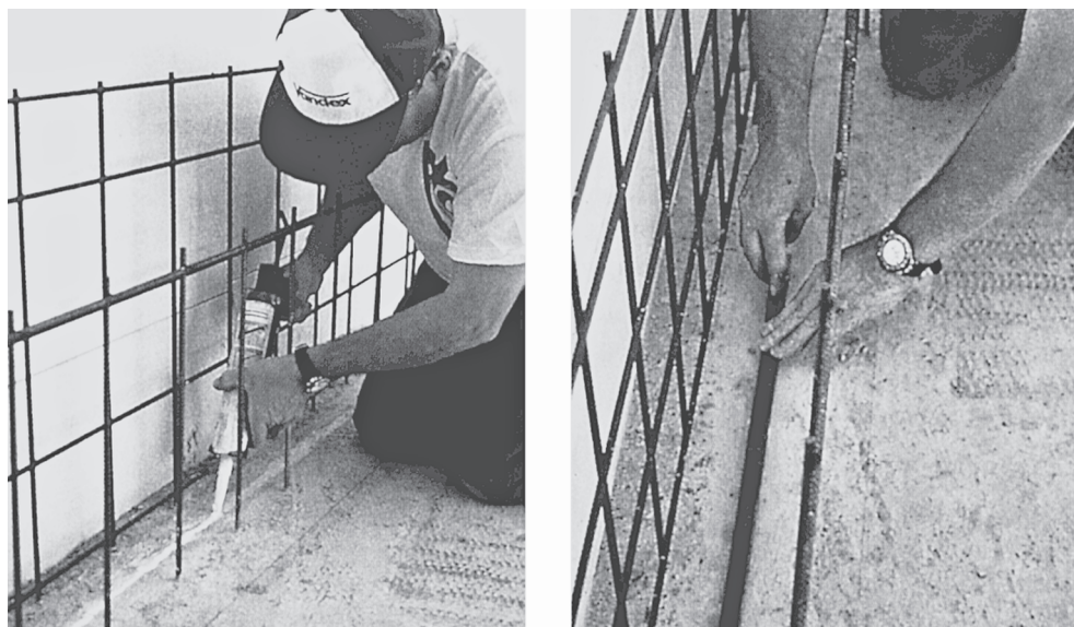
Рис. 2.33. Установка гидрошпонки разбухающего типа
