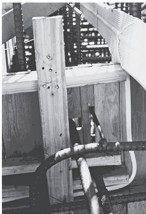
Рис. 2.31. Монтаж соединителя гидрошпонки из ПВХ в опалубке (предоставлено J.P. Specialties)
