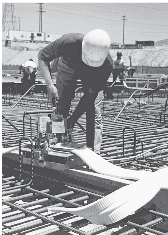
Рис. 2.27. Сварка гидрошпонки из ПВХ на строительной площадке ( предоставлено J.P. Specialties )
