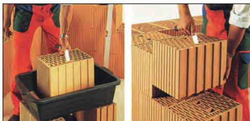
Рис. 3.12. Кладка стен из шлифованных строительных блоков
