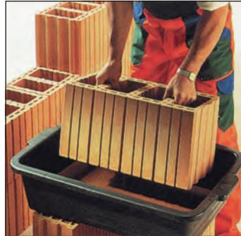
Рис. 3.16. Установка шлифованных заполняемых строительных блоков в шумозащитной стене
