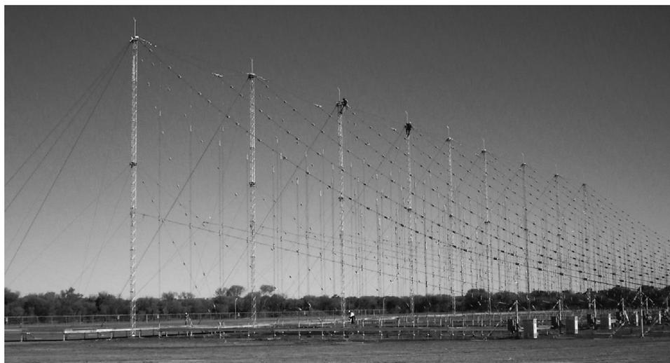
**Рис. 1.8.** Передающая антенна ЗГ РЛС Jindalee. Двухполосная линейная решетка с апертурой около 140 м состоит из 16 (ВЧ-полос) и 8 (НЧ-полос) равномерно разнесенных вертикально поляризованных ЛПДА-элементов. © Commonwealth of Australia 2011
